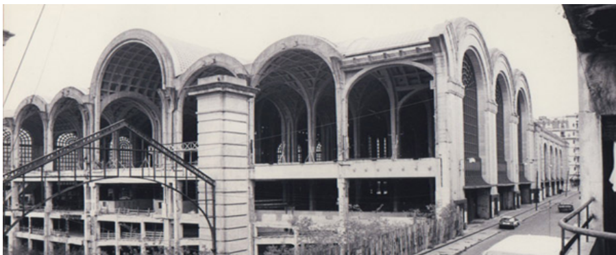
Figura 10. Detalle de la obra en construcción. 22
