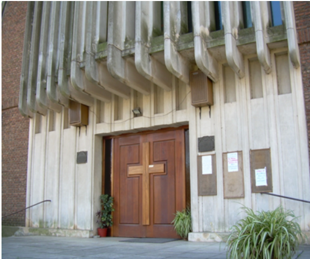
Figura 4. Detalle del frente y puerta. 14
