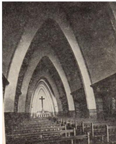
Figura 6. Interior de la capilla, vista de arcos de hormigón. 16
