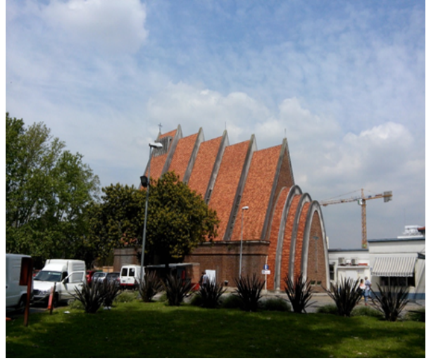
Figura 5. Vista del techo, lateral y pared trasera. 15
